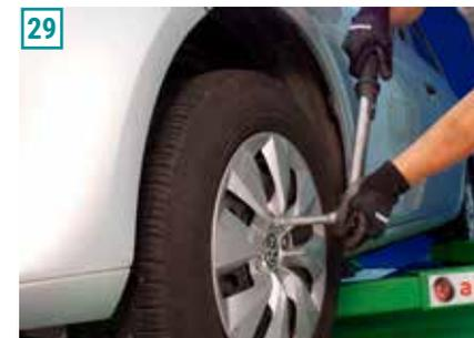
29) Na montagem das rodas, sempre aperte os parafusos com o torque correto: 100 Nm ( $\pm 20$  Nm).
